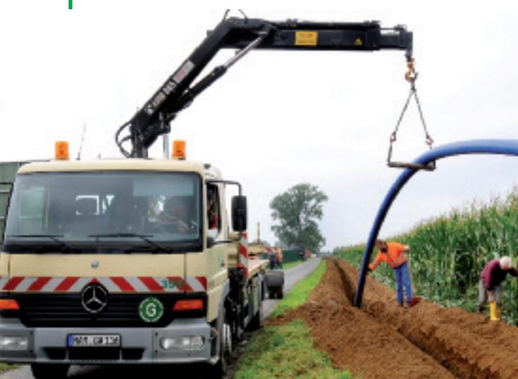
Leitungsverlegung an der Kümper Vöhde mit neuer Fräse.
